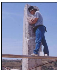
Επιδιόρθωση αναστηλωμένης παραστάδας του αρχαίου ναού στο Γύρουλα Νάξου μετά από πτώση του σε ακραία καιρικά φαινόμενα το 2003
